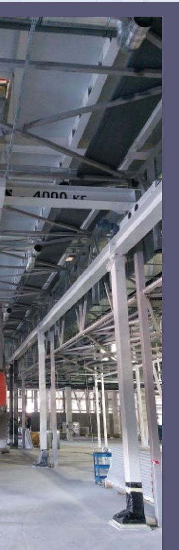
Reinraumkrananlage mit 4 t Traglast (im Bild 1 von 2 Anlagen)
